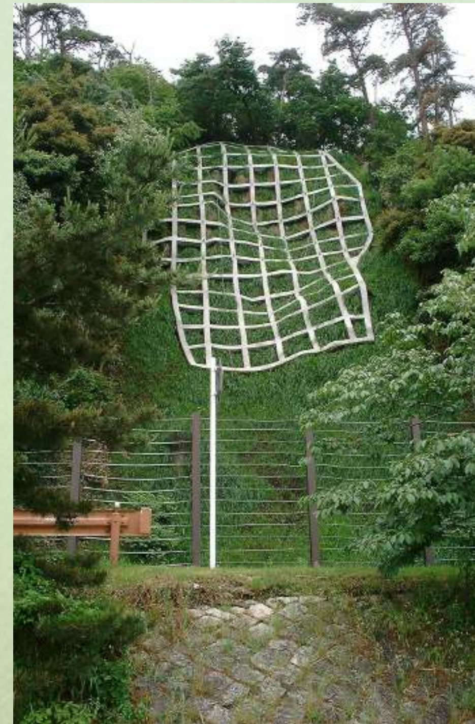
緑化処理現場
